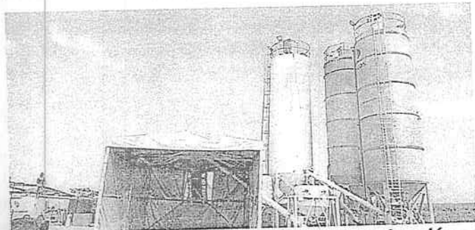
Fotografía No. 1 Línea uno (01) de producción –Planta dosificadora de concreto.
